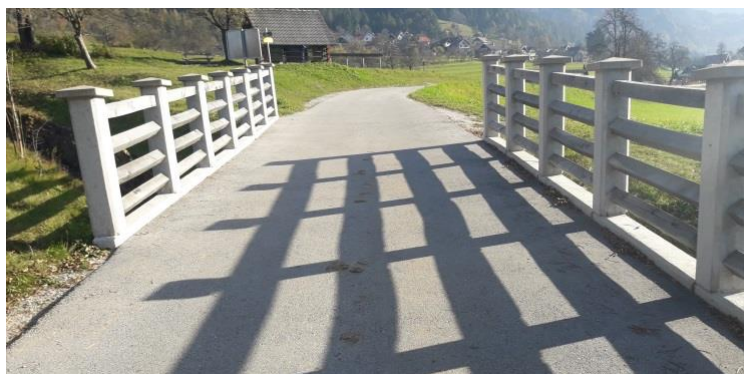
Slika 3: Že obnovljen most na trasi
